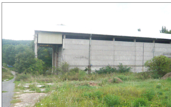
OBR.3 – BETONOVÁ SKELETOVÁ HALA AREÁLU ZA2 – POHLED OD SEVERU
